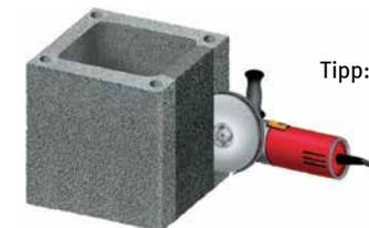
Typ: Der Schieberahmen der Putztür kann als Schablone verwendet werden.
